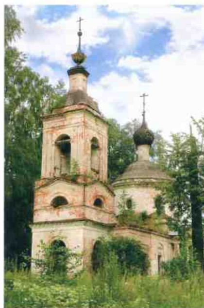
▲ Спасская церковь Вожажниково стоит «на отшибе», на въезде в село, но за деревьями ее можно и проглядеть...
